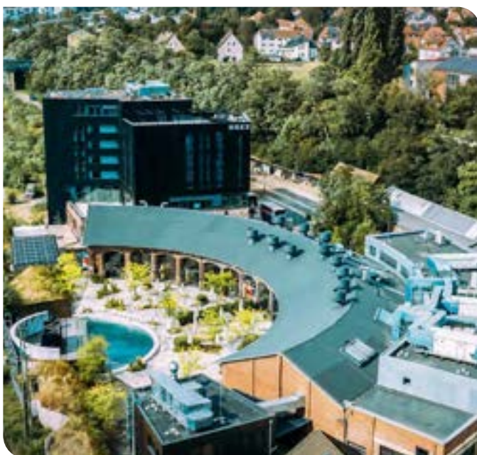
Der Lokschuppen Marburg
